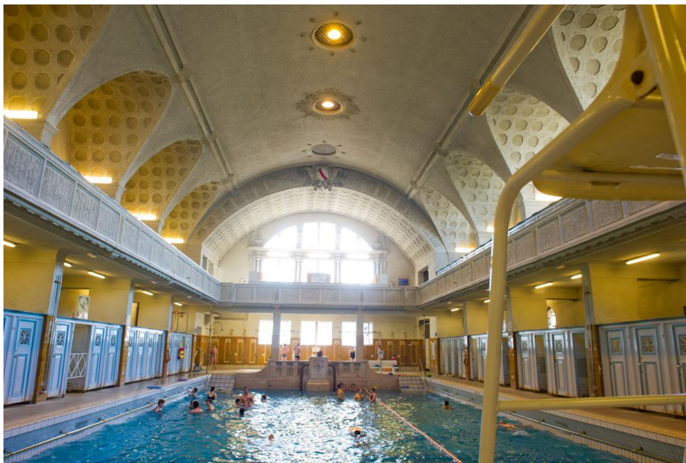
La rénovation des bains s'impose. La municipalité n'a pas encore arrêté les modalités mais n'exclut pas de conclure un partenariat avec un privé pour une partie de l'édifice, dont le sauna et le bain romain. PHOTO DNA – MARC ROLLMANN
